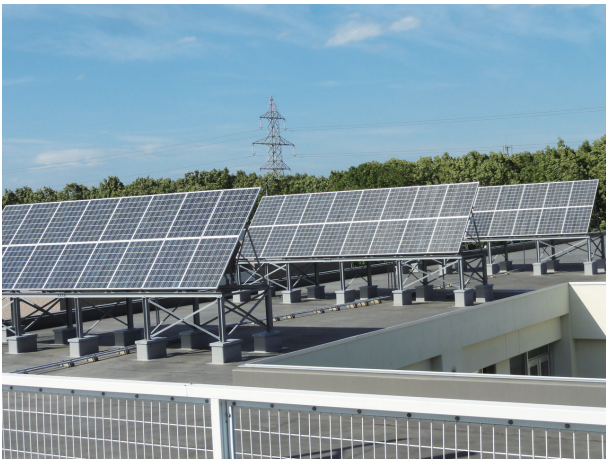
太陽光発電（札幌市立屯田北小学校）
