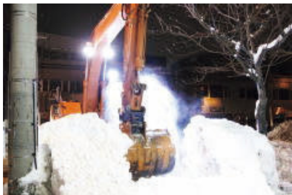
バックホウ（油圧ショベル）による排雪の様子
