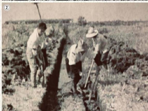
先人が人力で溝を掘り、北海道の農地は作られた。①排水のための溝を掘る。②溝堀りの道具に太刀と桃鉄が使われている様子。③土管を運ぶ。④土管を埋設する。①③④北洋映画社制作映画「土地改良」(1954年)より。北海道博物館所蔵。②「戦前の北海道関係映画フィルム(産業編)」(1936年)より。北海道立文書館所蔵、北海道博物館提供
