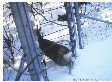
国道44号のワンウェイゲートを使って森側へ脱出するシカ。
