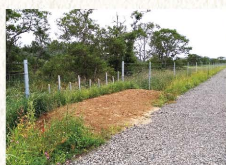
厚岸町内を走る国道44号のアウトジャンプにはポールも付加され、より侵入しにくい構造になっている。
