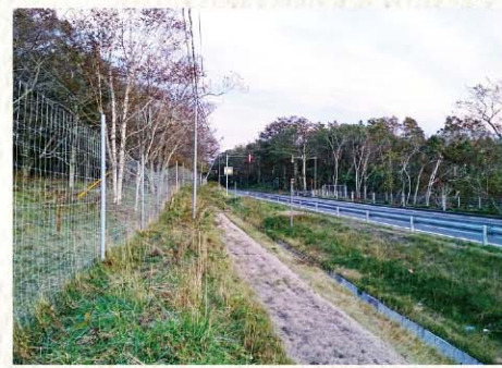
釧路町に設置された侵入防止柵。
