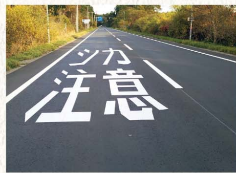
「シカ注意」の路面表示は、走行中の車の運転席から瞬時に読み取れるよう、縦長の書体となっている。
