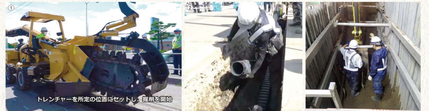
① 工事工程を一台で完結できるトレンチャー。② 地下60cmで配線等を保護できることが実験でわかり、浅い施工に。③ 凍結防止のため深く掘り、コストがかかっていた従来の施工。写真提供=国立研究開発法人 土木研究所 寒地土木研究所
