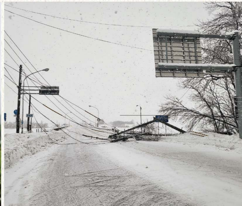
地震、台風、大雪などの自然災害で電柱が倒れて道路をふさいでしまったり、断線で停電してしまうリスクが、地上電柱にはある。写真提供=国立研究開発法人 土木研究所 寒地土木研究所
