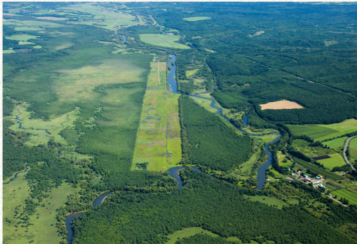
2011年、旧川復元した後の釧路川(茅沼地区)。写真提供=国土交通省北海道開発局釧路開発建設部
