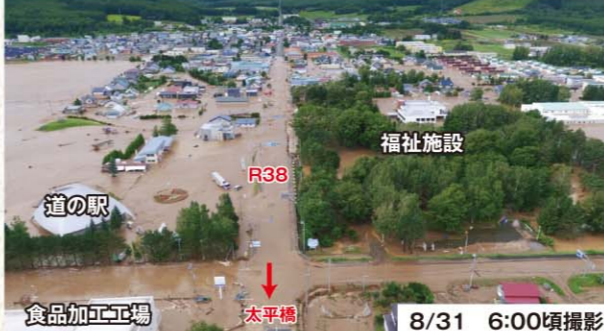
平成28年水害で空知川が氾濫した金山ダム上流の南富良野町市街地。
