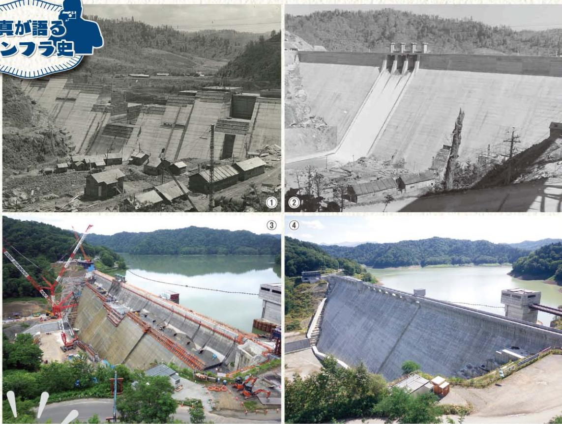
①桂沢ダム建設のため、昭和28年から上桂沢集落の人々が移転。②桂沢ダムは北海道初の多目的ダムとして昭和32年に供用開始。③より高機能に生まれ変わるため、桂沢ダムの再生が始まる。④桂沢ダムを嵩上げし、令和6年3月に新桂沢ダムが完成。
