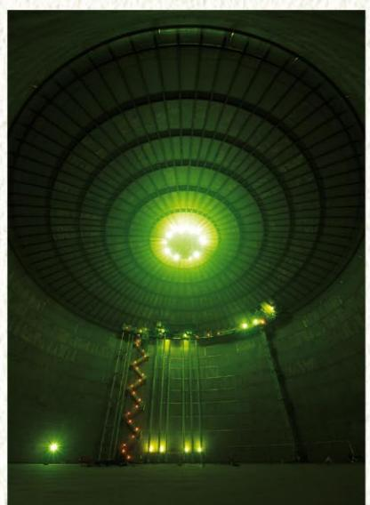
LNGで満たされる前のタンク内部。高性能の魔法瓶構造によってLNG自体の冷熱でマイナス160℃が保てる。写真提供=北ガス
