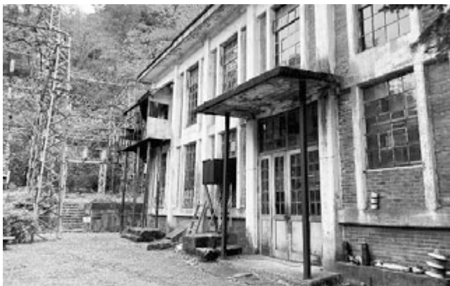
旧幌内炭鉱変電所
